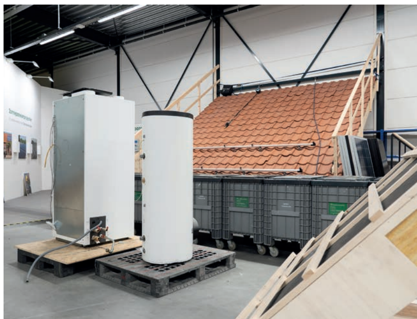
Bevestiging van pv-panelen in de trainingsruimte. Op de voorgrond warmtepomp met tapwaterbuffer.
