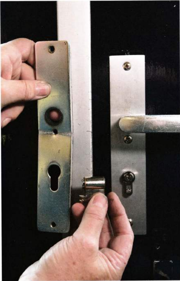
Via de 'Roemeense' methode binnengekomen; slotplaat ombuigen en het cilinderslot met een bahco draaien tot het breekt.
